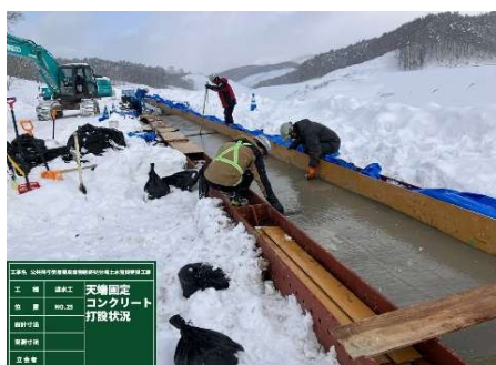
遮水工（固定工）
